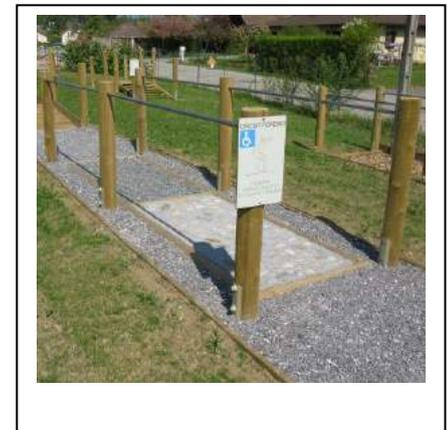
Pour la plupart des agrès : des appuis ancrés sur des platines en acier galvanisés et thermolaqués qui permettent une maintenance plus aisée en cas de réparation ...
